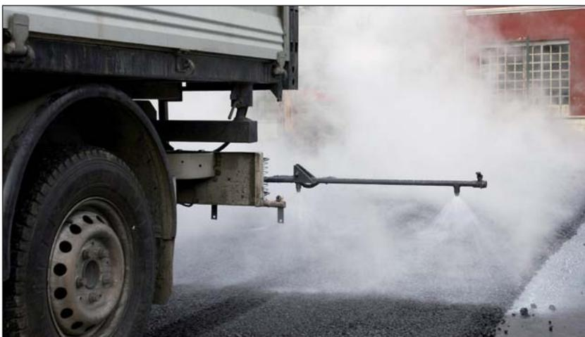
Figura 13 - Un esempio di spruzzatura dell'emulsione fotocatalitica
