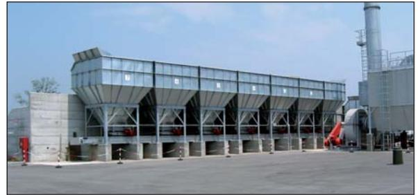
Figura 20 - Le tramogge del materiale inerte
