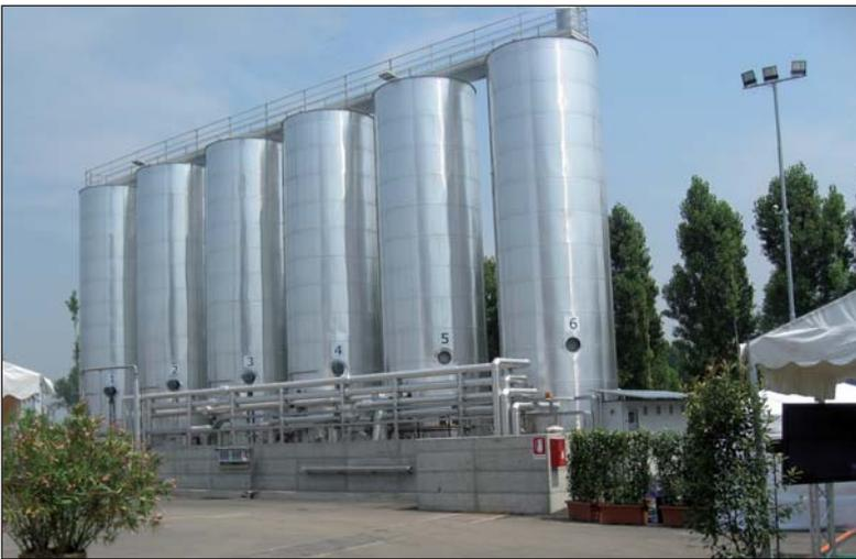
Figura 18 - I serbatoi verticali del bitume riscaldati elettricamente
